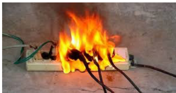
Sobrecarga de equipos eléctricos
